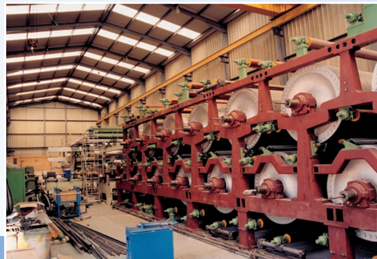
Montaje de una máquina en taller Paper machine pre-assembly in the shop Монтаж одной из БДМ в цеху
